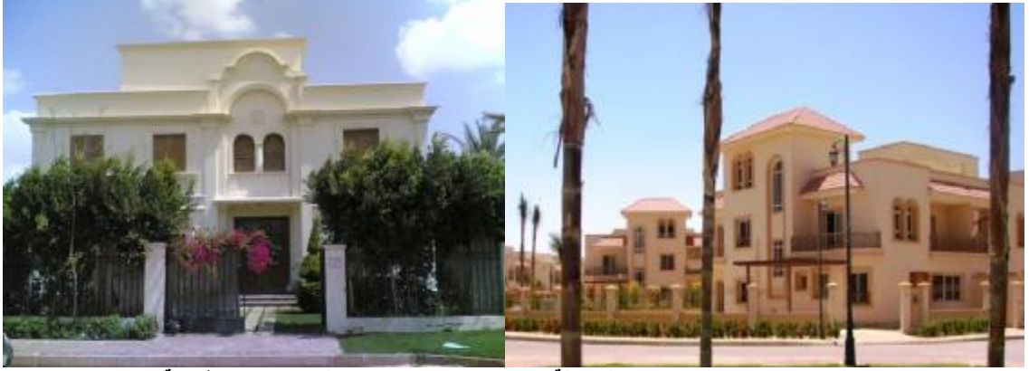
شكل (١٦) استخدام القرميد و اسقف مانلة استخدام مفردات بملامح اغريقية بتجمع تارا بعض ملامح اندلسية تجمع جرينز المصدر: ( ماجده متولى- سحر سليمان- أيمن حمزة وآخرون، ٢٠١٤ - ٢٠١٥ ).
