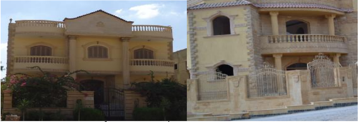
شكل (١٤) إستخدام البرامق و القرميد فى واجهات لفيلات سكنية بتجمع الياسمين المصدر: ( ماجده متولى- سحر سليمان- أيمن حمزة وآخرون، ٢٠١٤ - ٢٠١٥ ).
