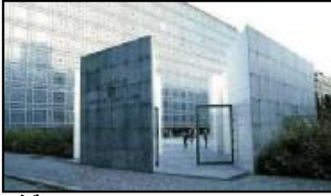
شكل (٢٢) استخدام المشربيات بصورة حديثة في مبنى معهد العالم العربي بباريس المصدر : نيفين فرغلي بيومي، التطبيقات المعاصرة للمشربية كموروث ثقافي، ورقة بحثية، ٢٠١٦.
