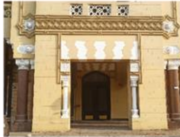
صورة (٥٢) مدخل البرج بمنصف المبنى.
