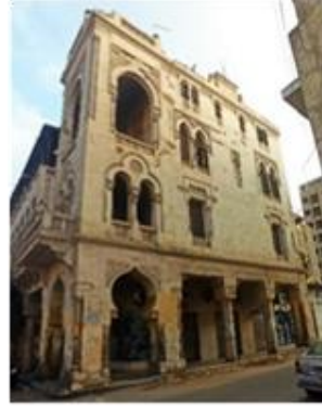
صورة (٢٧) واجهة المبنى الجانبية
