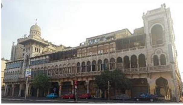
صورة (٢٨) واجهة المبنى الأمامية
