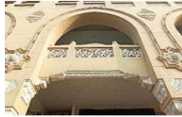
صورة (٥٠) استخدام وحدات من الجبس المشغول بزخارف نباتية في بطن العقود المستقيمة للبانكة.
