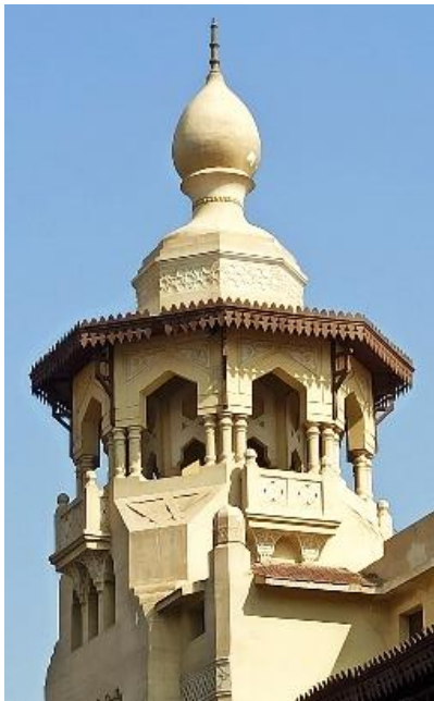
صورة (٧) توضح شكل المنطقة الانتقالية بالبرج، والجوسق، والخوذة البصلية.
