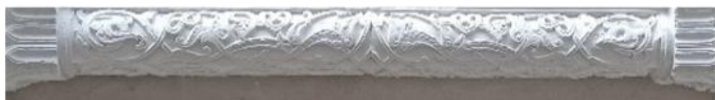
صورة (٥٨) وحدات من الجبس المشغول بزخارف نباتية في بطن العقود المستقيمة للبانكة.
