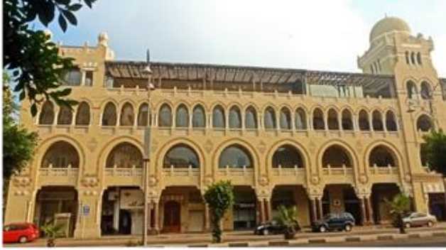
صورة (٤٩) واجهة المبنى الأمامية
