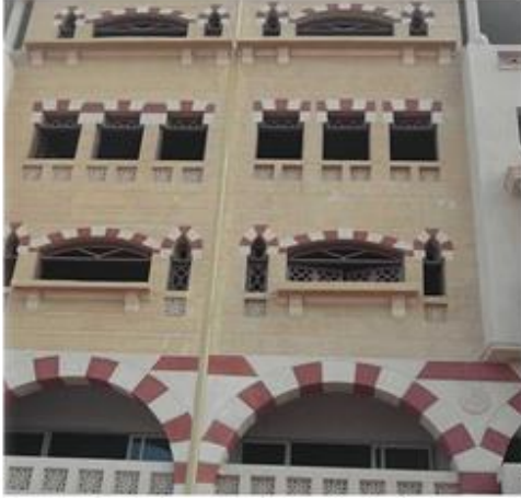
صورة (٧٣) استخدام العقد "الموتور والمستقيم والنصف الدائري" في الواجهات الأمامية، واستخدام العقد الدائري المرتد المدبب في الواجهات الجانبية.
