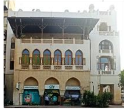
صورة (٤٨) واجهة المبنى الجانبية
