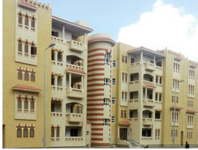
صورة (٧٤) من الموقع توضح تصميم الواجهة الخلفية للمبنى، والتي توضح المداخل وتوزيع فتحات النوافذ الخاصة بالخدمات والدرج.
