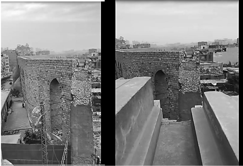
صور تبين مقدار وشكل النحر أو القطع في السور من عند محطة مترو السيدة زينب.
