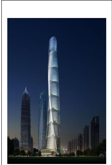
برج شنغهاي ثاى أعلى مبنى فى العالم تم الانتهاء من تنفيذه عام 2015 يبلغ ارتفاعه 632 م
