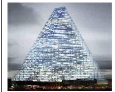
برج المثلث بباريس أول ناطحة سحاب يسمح بها في باريس بعد 40 سنة من القيود على الارتفاعات، متوقف اجرائيا لكن البلدية اعتمدت التصميم عام 2015
