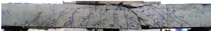
f) Girder BF.
