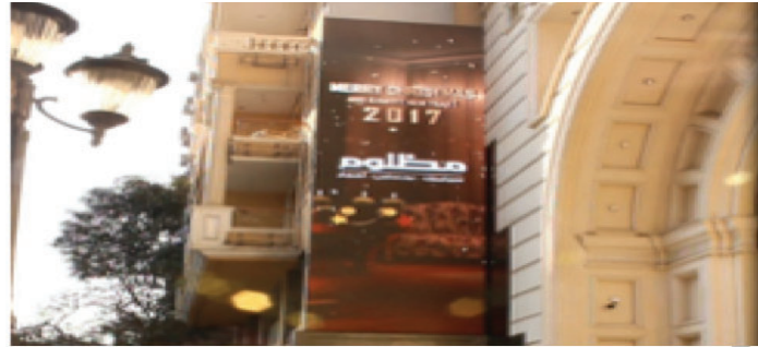
شكل ٤ مشكلة موقع وحدة الإعلان على واجهة مبنى سكني شارع مصدق، الدقي
