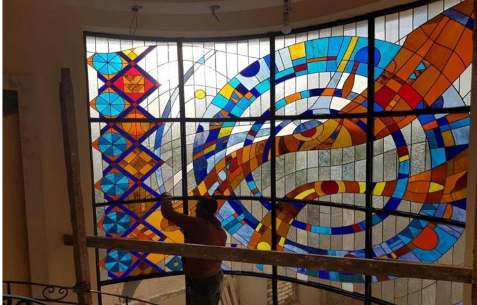
شكل(٢٢) يوضح الواجهة الزجاجية اثناء التركيب (من تصوير الباحثة-٧-٢٠٢٢)
