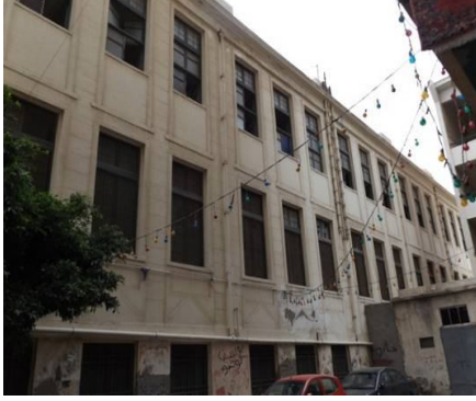
لوحة رقم (4) الجزء الأخير من الواجهة الغربية الأصلية يمثل جزء من مبنى المدرسة الأصلي . تصوير الباحث
