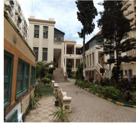
لوحة رقم (1) منظر عام لمدرسة العباسية الثانوية العسكرية بنين بشارع جرين متفرع من ميدان منشأ – بحي محرم بك. (تصوير الباحث)
