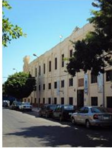
لوحة رقم ( ٢ ) الواجهة الشمالية ( الرئيسية ) لمدرسة محمد علي الزخرفية والمعمارية. ( تصوير الباحث )
