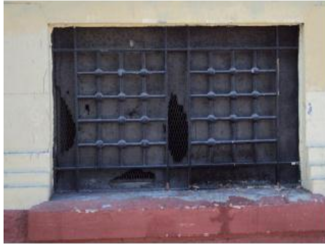
لوحة رقم ( ٣ ) إحدى نوافذ الطابق الأرضي للواجهة الشمالية. ( تصوير الباحث )
