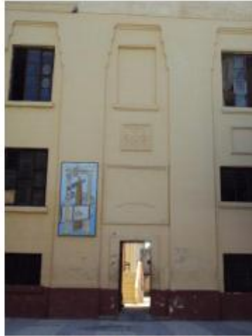
لوحة رقم (١٣) المنخل الفرعي الثاني بالواجهة الشمالية على يسار المنخل الرئيسي الحالي، يعطوه إطار مستطيل يعطو فتحة المنخل مكون من عتب مستطيل يعطوه عقد عاتق مزخرف بصنجات مزررة بينهما نفيس.
