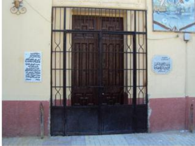
لوحة رقم (٧) المدخل الرئيسي الحالي ( المدخل الفرعي الأول ) بالواجهة الشمالية يغلق عليه باب حديدي حديث. ( تصوير الباحث )
