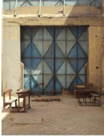
لوحة رقم (١٨) البوابة الحديدية التي تغلق على المدخل الرئيسي للمدرسة وتظهر من الداخل أشكال المعينات. ( تصوير الباحث )
