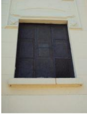
لوحة رقم (٤) إحدى شبابيك الطابق الثاني من الواجهة الشمالية يعلق عليها درف من الخشب والزجاج . ( تصوير الباحث )
