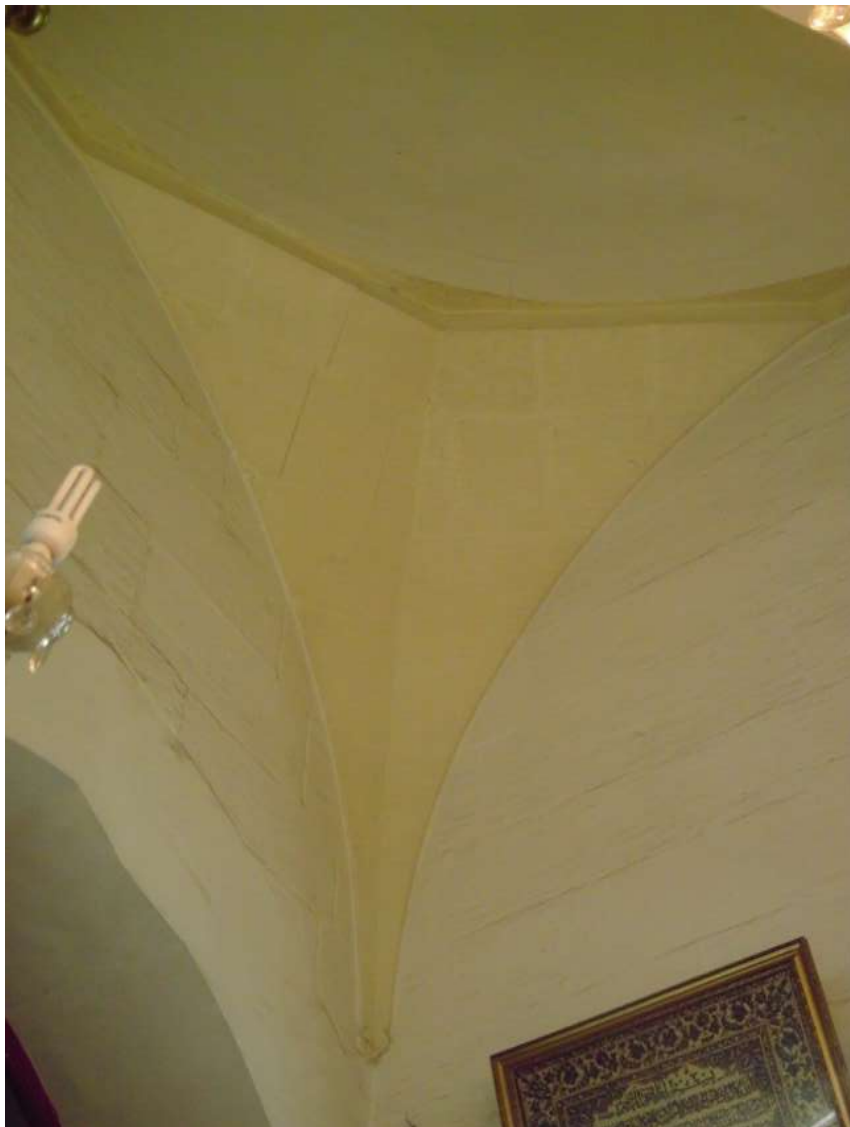
لوحة رقم (١) المثلثات الهرمية في منطقة الانتقال من الشكل المربع إلى الشكل الدائري، تصوير الباحث
