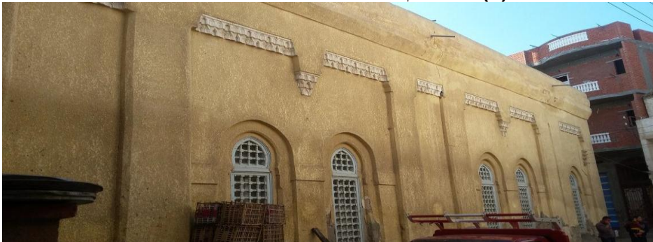
لوحة (٤) الواجهة الشمالية الشرقية
