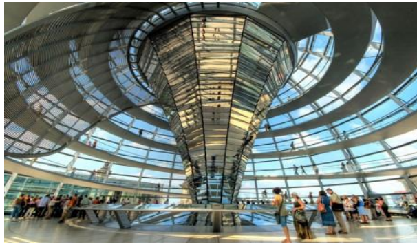
صورة رقم (10) نموذج العمارة ذاتية الإمداد بالطاقة – توضح استخدام المرايات العاكسة لتوصيل الإضاءة الطبيعية لغرفة الاجتماعات تحت الأرض (مبني البرلمان الألماني) (3)
