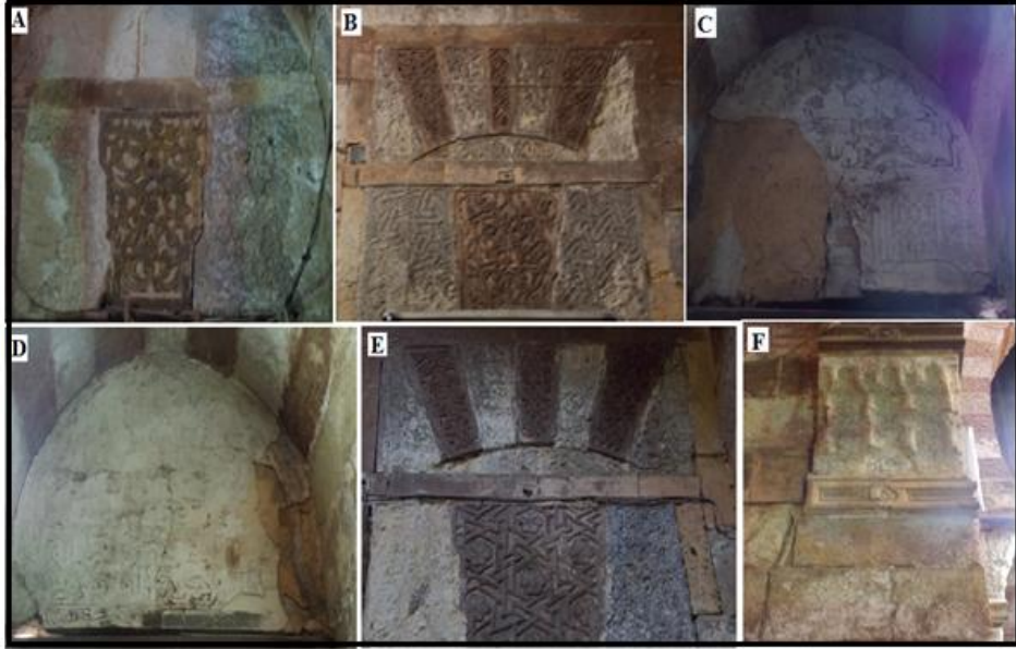
صورة رقم ( ٤ ) توضح فقدان لبعض الأجزاء من الزخارف نتيجة تأكلها وتساقطها بفعل الاملاح ( تصوير الباحث )
