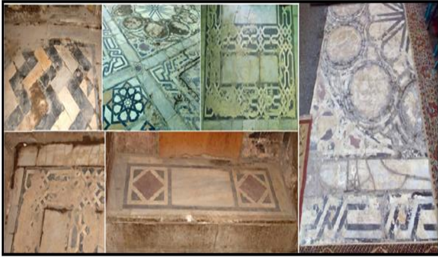
صورة رقم ( ٢ ) توضح بعض نماذج لمظاهر تلف الارضيات الرخامية من مدرسة ازبك اليوسفى ( تصوير الباحث )
