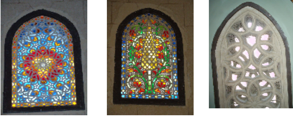
شكل ٢٨ (أ) يوضح فتحة من الجبس المفرغ بالقبعة من أعلى بعد الترميم
