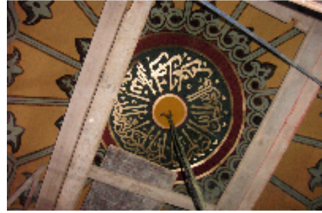
شكل ٢٧ (ج) يوضح القبة بعد إظهار الطبق
