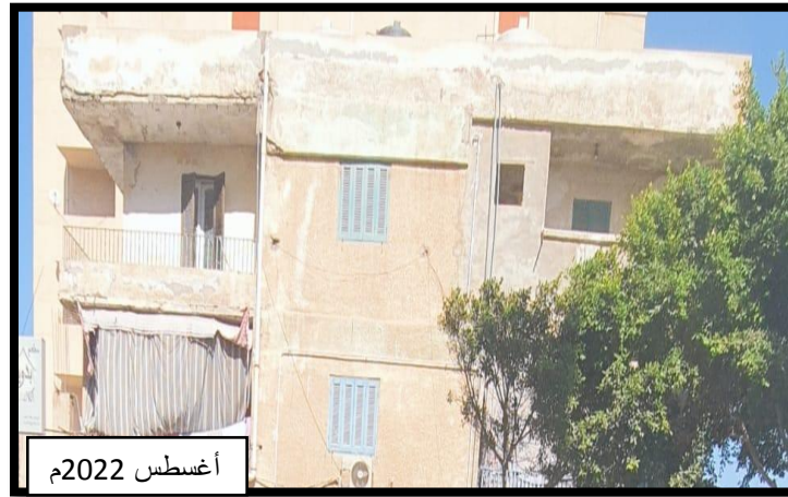
صورة (6) مبنى مكون من طابقان بشارع عمر المختار في منطقة المطاعم
