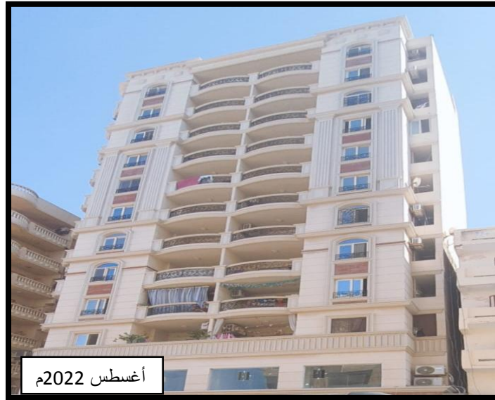
صورة(5) مبنى مكون من خمسة طوابق فأكثر بشوارع التحرير في منطقة الأوقاف
