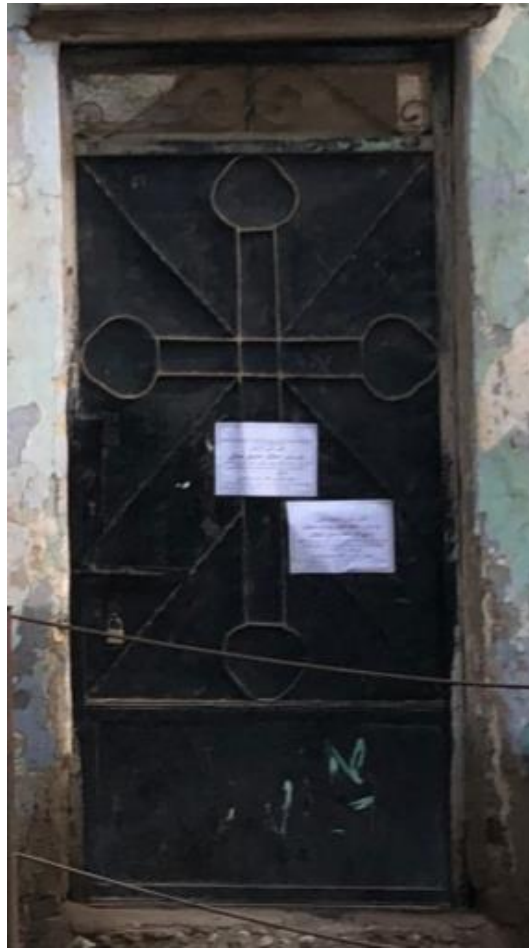
لوحة رقم (٤) توضح المدخل الرئيسي بالواجهة الغربية.
