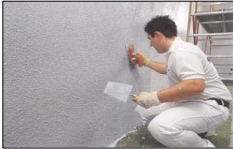
شكل (7) يوضح استخدام طلاء منقي للهواء، حيث تقوم تقنية النانو بتطوير إمكانيات وخواص الطلاءات فمنها الطلاءات التي تقوم بالتنظيف الذاتي والطلاءات عازلة للصوت وغيرها. المصدر: (5) بتصرف
