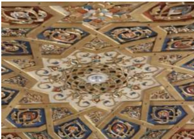
صورة (29)، نموذج لسقف ذو طابع إسلامي تم طباعة أجزائه ( حشواته الداخلية) بتقنية الطباعة ثلاثية الأبعاد باستخدام خيوط بلاستيك ( ABS ) سمكها 5 مم ، تم تقسيمه لأجزاء صغيرة حتى يمكن طباعته ثم تم تجميعه وتلوينه وتذهيبه ، استغرقت عملية الطباعة 3 أسابيع وعملية التركيب في السقف يومان - عام 2014
