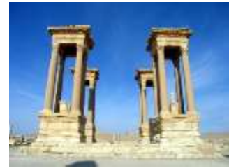
صورة (25) الترابليون الأصلي ( ميني اثري بتدمر- سوريا- عبارة عن منصة حجرية مرتفعة تضم أربعة هياكل متطابقة كل هيكلمؤلف من أربعة أعمدة مرتكزة في كل ركن من أركان الهيكل - وقد تم تدمير أغلب المبنى في الصراعات الحالية ولم يبق إلا 4 أعمدة من أصل 16 عمود ).
