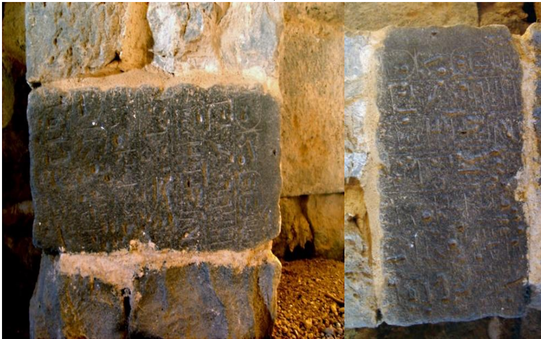
(شكل ٦) صورة للمسلة مبنية في قوس المبنى © تصوير يوسف الزعبي
