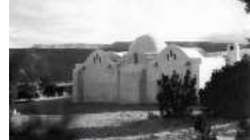
شكل (29) مسجد دار الإسلام بنيو مكسيكو حيث أراد سكان المنطقة استخدام القبو والقبو النوبيون المستخدمين في النوبة - مصر
