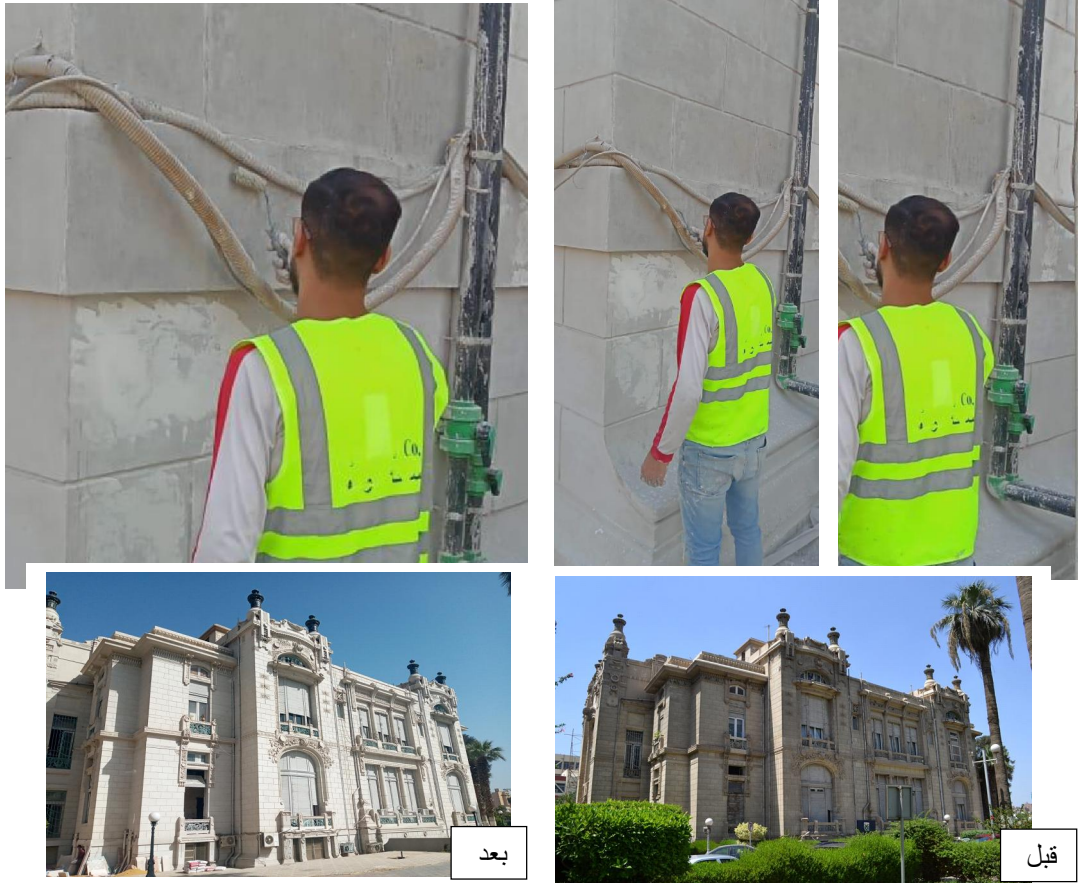
شكل ١٨: يوضح ترميم الحجر الصناعي بالواجهات الخارجية للقصر.
