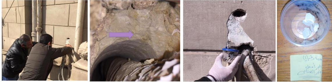
شكل ١٠: يوضح طريقة أخذ العينة (عمل الباحث)
