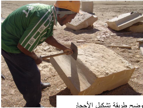
صورة ٥: توضح طريقة تشكيل الأحجار
