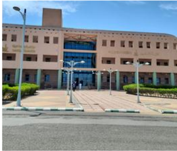
(شكل 10) واجهة مبنى كلية العلوم - تصوير الباحث
