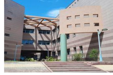
(شكل 13) واجهة مبنى كلية العلوم - تصوير الباحث
