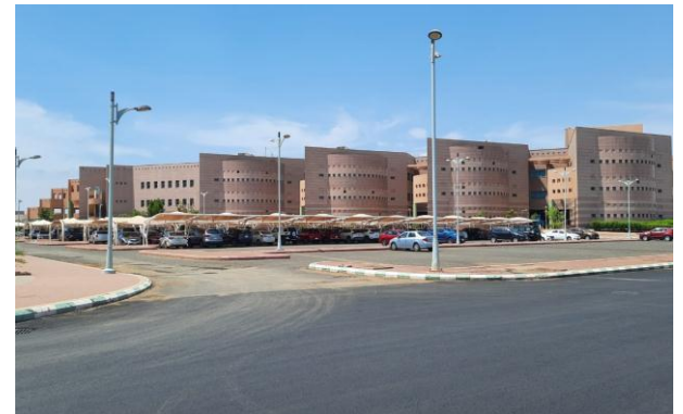
(شكل 14) واجهة مبنى كلية العلوم - تصوير الباحث
