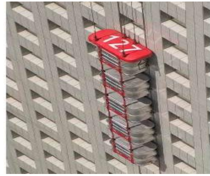
(شكل 17) أنظمة إنقاذ المنصات لإخلاء المبني
