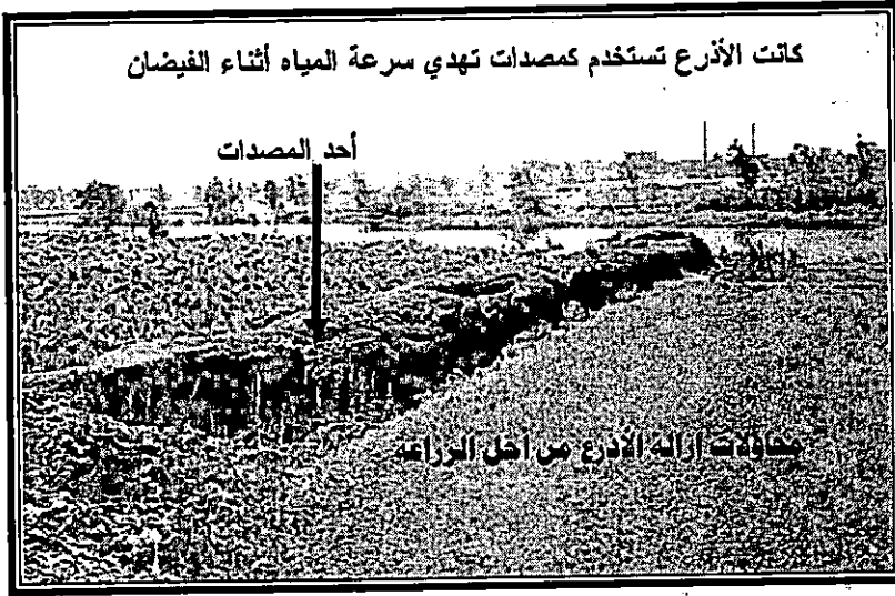
صورة رقم (١٣) تستخدم الأذرع العرضية كمصدات تهدئ سرعة مياه الفيضان
