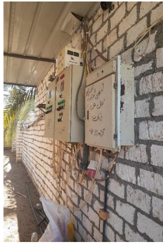
١٢- سقف معزول بمزرعة الراشدة ١٣- لوحات التحكم بالإضاءة والتدفئة بالراشدة ١٤- استخدام الطاقة الشمسية بمزرعة موط نوفمبر ٢٠٢٢
