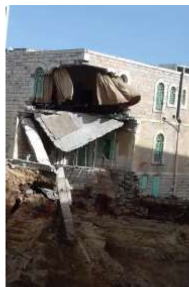
(لوحة ٦) صور توضح الهدم جزئي للمبنى نتيجة الحفريات للبناء التجاري الملاصق للمبنى القديم حيث انهارت زاوية المبنى نتيجة الاهتزازات الناجمة من الحفريات المجاورة. © تصوير الباحث، ٢٠٢١.
