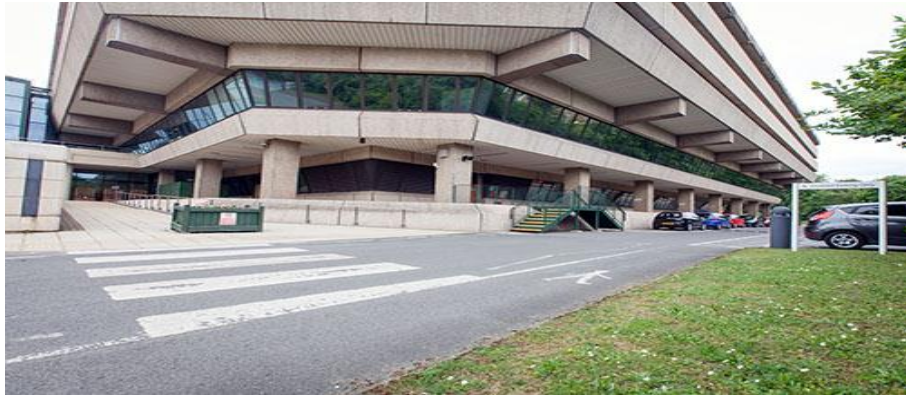
منظر لخليج وقوف السيارات التي يمكن الوصول إليها ومنحدر المدخل الخلفي
