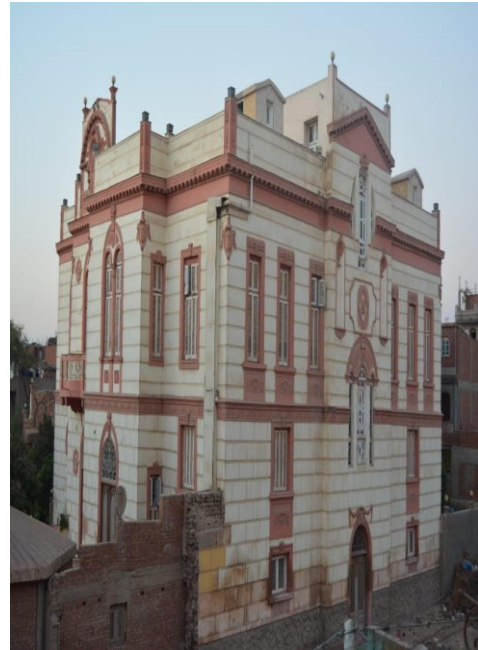
لوحة (٦) الواجهة الجنوبية لقصر أحمد
