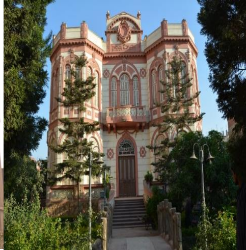
لوحة (٢) الواجهة الشمالية لقصر أحمد
