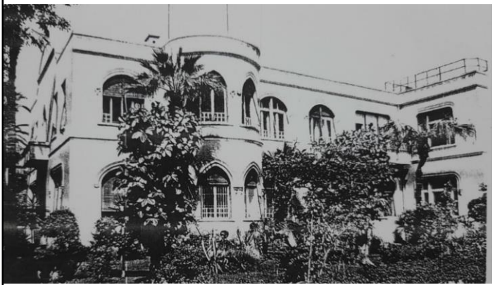
لوحة (١٢) الواجهة الشرقية - كلية رمسيس للبنات - شارع رمسيس، عن الزيني، المنشآت التعليمية في مصر.
