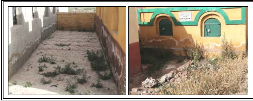
لوحة (٦) آثار الرشح المائي على جدران الجبانات (جبانة بتيس، ٢٠١٩م)
