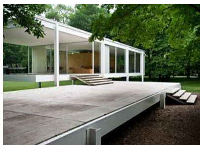
The Farnsworth House (Ludwig Mies Van Der Rohe، ١٩٥١ (هو الحدائثة مبنى بهيكل من الصلب. يتم أخذ المساحة الموجبة بواسطة ثلاثة ألواح مستطيلة أفقية والأعمدة الرفيعة التي تدعمها.
