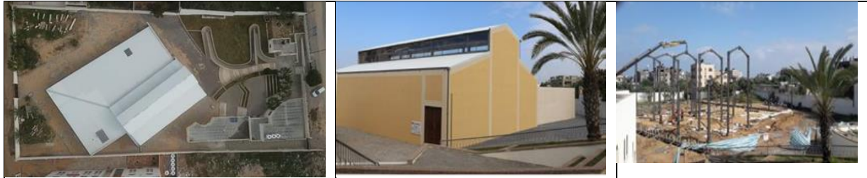
شكل (12) صور تنفيذ المقترح الثالث لحماية أرضيات فسيفساء الكنيسة البيزنطية بجباليا – المصدر: الباحث
