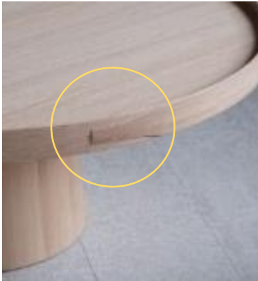
صورة (٥١) صور توضح وصلة الذيل المشقوق https://www.dezeen.com/2017/01/20/pinch-design-rodan-coffee-table-shaker-design-principles-furniture-maison-objet-2017/
