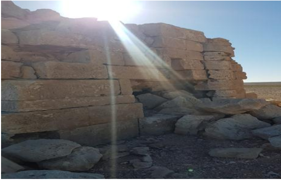
صورة (٥) أجزاء من الأحجار السفلية لأعمدة المبنى متهدمة على الأرض-تصوير الباحث
