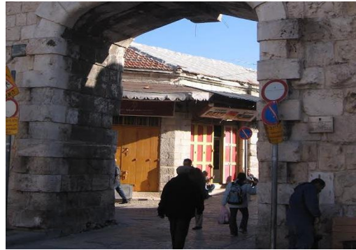
تداعي شبكة الطرق وإهمالها في البلدة القديمة شكل ٧
