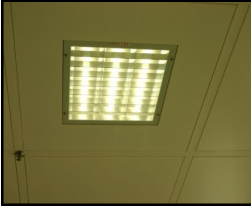
(ب) وحدات الإضاءة بنفس مستوي السقف المعلق
