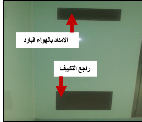
(أ) إستخدام التكييف المركزي بفلاتر تنقية الهواء
