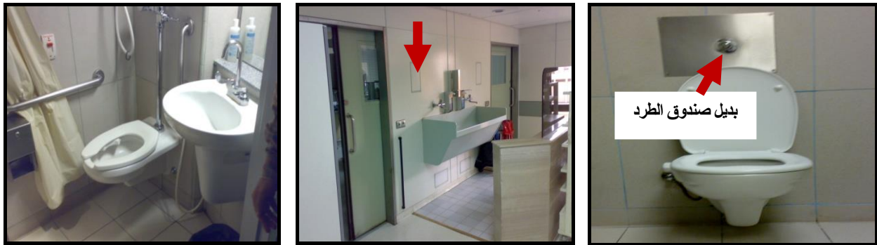
مواسير مدفونة كبديل لصندوق الطرد خلاطات مياه تفتح دون اللمس باليد اجهزة مرفوعة وقواعد مراحيض مفتوحة شكل (٤) مواصفات نوعيات مواد التشطيبات المختلفة لمكافحة العدوي
