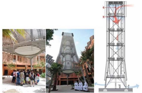
شكل رقم 10: الأول يوضح عمل برج التبريد المصدر: [12]. الثاني هو: يوضح طول برج التبريد وانخفاض درجة حرارة الهواء الخارجة منه. المصدر: [12]. والثالث هو: برج التبريد بمدينة مصدر مزود بتقنية معقدة للتحكم في إتجاه الرياح وجودة الهواء وتبريده كأحدث تطور للcooling tower. المصدر: [19].
