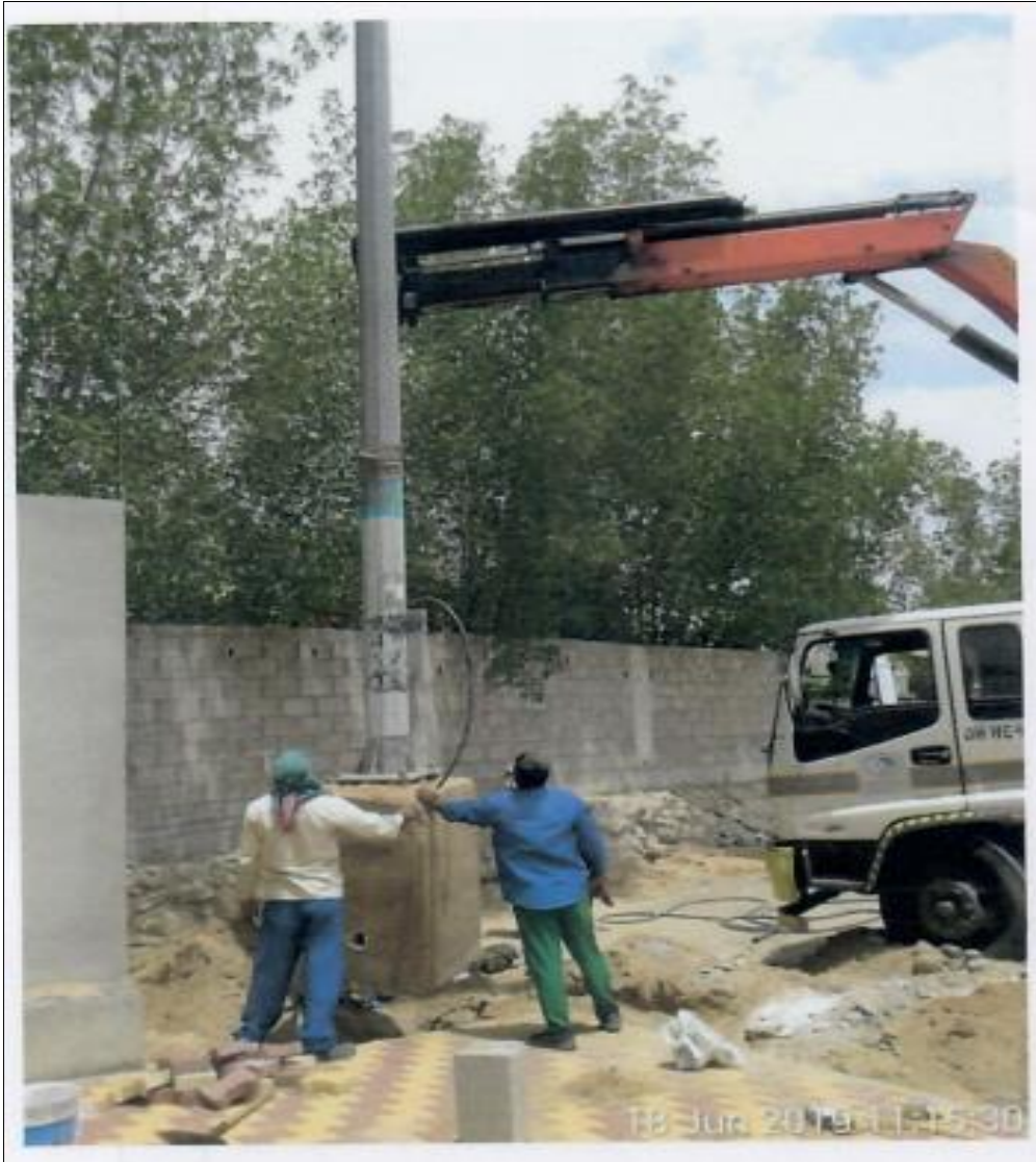
صورة (9) أعمال تركيب أعمدة الإنارة مخطط الزهراء منطقة الشرائع، عام 2022م
