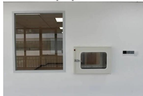
شكل (٢٢): مصاعد التنظيف لتسليم الادوات النظيفة بالمستشفى
