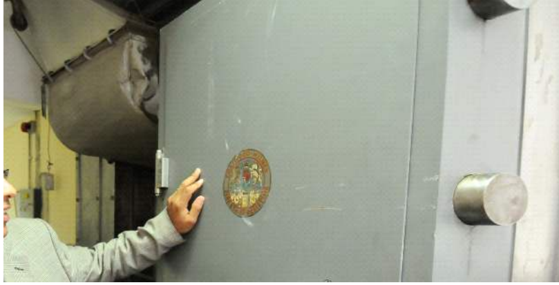
٢- باب الخزانة الرئيسية التي احتوت على خزن صغيرة لحفظ مقتنيات الأفراد وهي محصنة ضد الانفجارات
