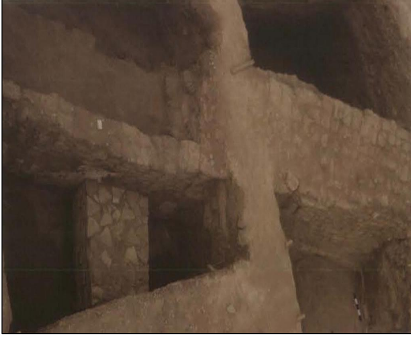
لوحة رقم 6: جزء من سور المدينة المبني على شكل مداميك من طوب اللبن يربط بينها مونة طينية. (العمير، وآخرون، أطلال 19، ص 388).
