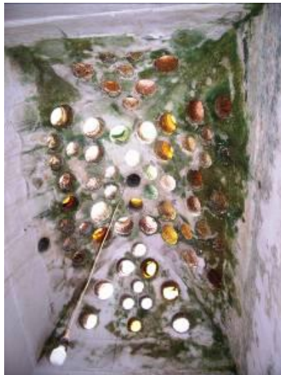
لوحة (١٢): وسطاني الحمام – سقف أحد الخلوات الفرعية من الداخل بالوسطاني الثاني تصوير الباحث
