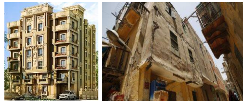
شكل (10) مبنى حالته جيدة شكل (11) مبنى حالته رديئة
