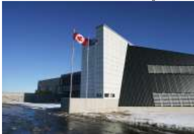
صورة (12) الواجهة الأمامية لمعهد التدريب وخدمات الحريق والطوارئ لمطار تورنتو بيرسون الدولي
