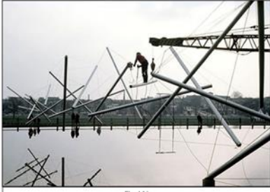
شكل (19) يمثل تحول الهيكل الى سقالات ذاتية
