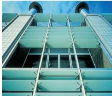
شكل (5) نظام التظليل الخارجى للشمس والظل شكل (6) اجهزة الاستشعار بين وحدات الاناره الفلورسنتيه
