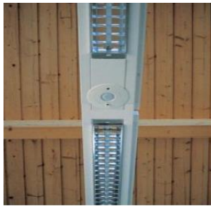
شكل (5) نظام التظليل الخارجى للشمس والظل شكل (6) اجهزة الاستشعار بين وحدات الاناره الفلورسنتيه
