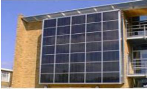
شكل (4) الخلايا الكهروضوئيه فى الواجهه الجنوبيه
