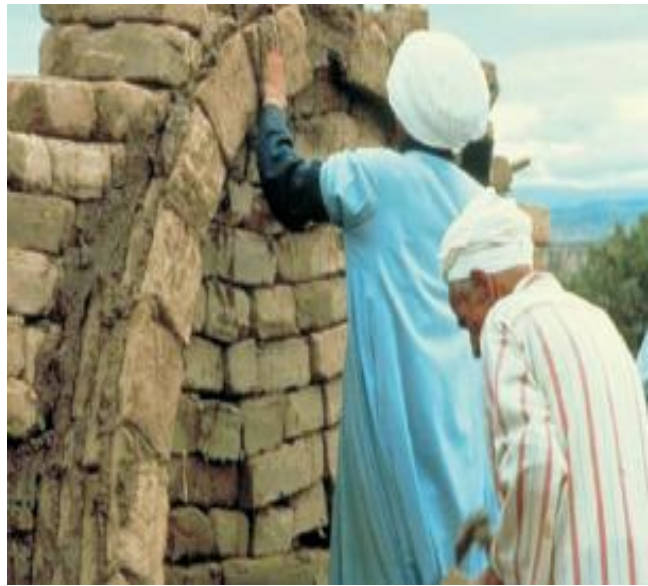
شكل ٧: طريقة بناء القبو النوبي في قرية دار الإسلام في نيو ميكسو بأمریکا عام ١٩٨٠ حيث قام حسن فتحي بإحضار اثنين من البنائين النوبيين وذلك لتعليم المعماريين والحرفيين المحليين طريقة بناء العقود والأقبية والقباب من الطوب الطيني [١٧].
