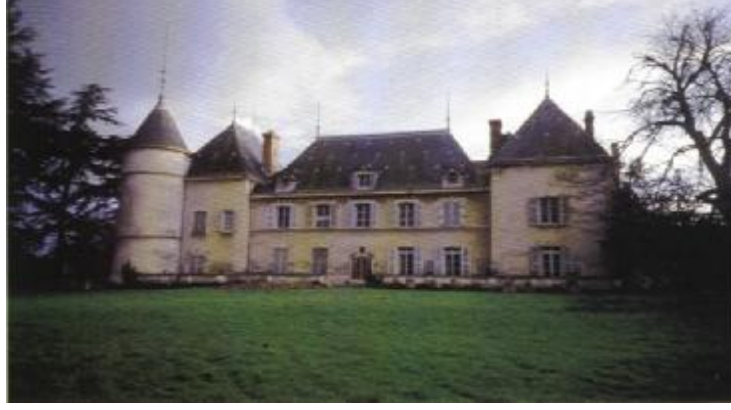
قصر مشيد بتقنية التراب المدكوك بضواحي ليون بفرنسا من القرن التاسع عشر الميلادي
