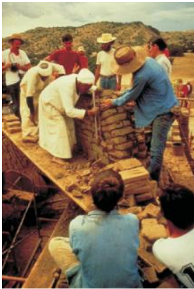
شكل ٧: طريقة بناء القبو النوبي في قرية دار الإسلام في نيو ميكسو بأمریکا عام ١٩٨٠ حيث قام حسن فتحي بإحضار اثنين من البنائين النوبيين وذلك لتعليم المعماريين والحرفيين المحليين طريقة بناء العقود والأقبية والقباب من الطوب الطيني [١٧].
