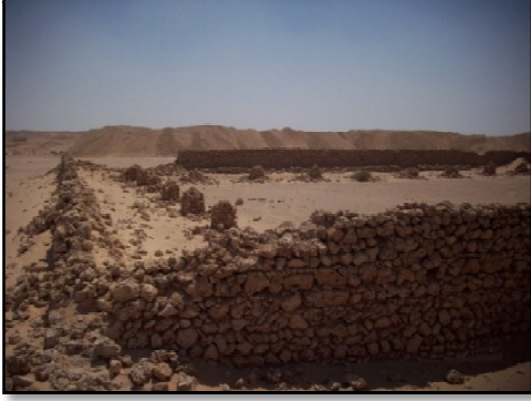
لوحة (١٢) تبين الجدارين الشمالي ، والشرقي للخان الثاني ، وبقايا دعامات البانكة حول الصحن ، وجانب من الجدران الداخلية للغرف المبنية خلف الجدار الرئيسي الغربي
