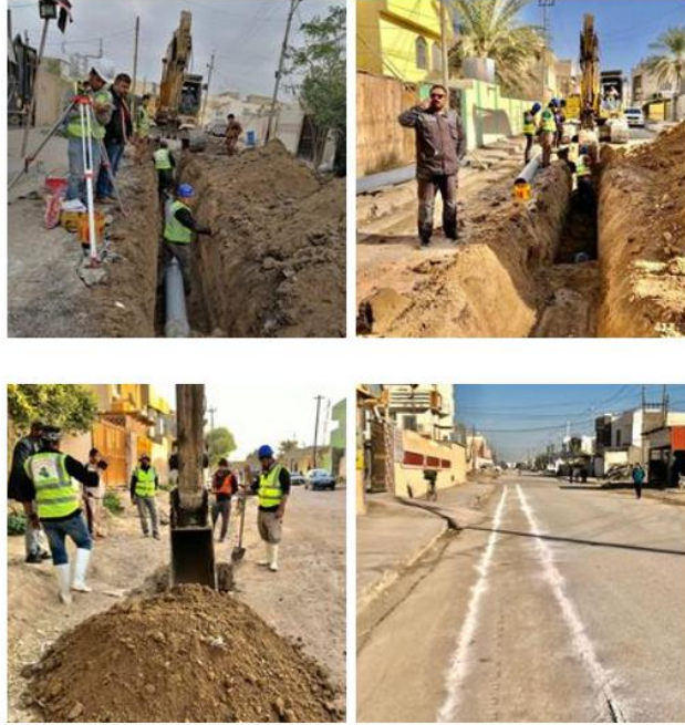
الشكل (1): مشروع تصميم وتجهيز وتنفيذ وتشغيل وصيانة مجاري الرمادي
