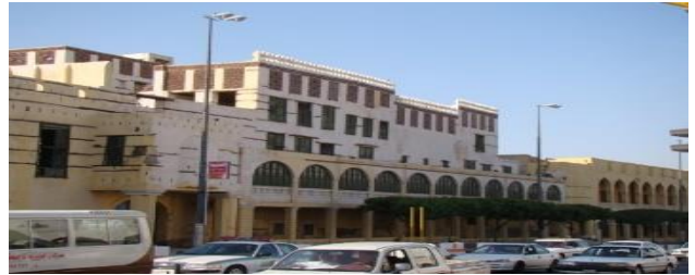
شكل (6) مظاهر تدهور القيم الجمالية بالمباني ذات القيمة مكة المكرمة - السعودية. المصدر:
